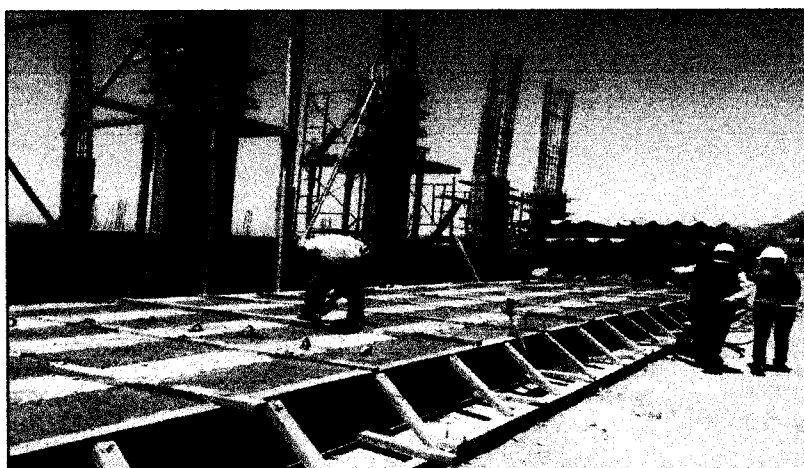
Imagen 15. Encofrado de columnas y placas zona de frío.
