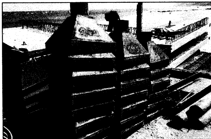
Imagen 11. Puntas para pilotes fabricadas.
