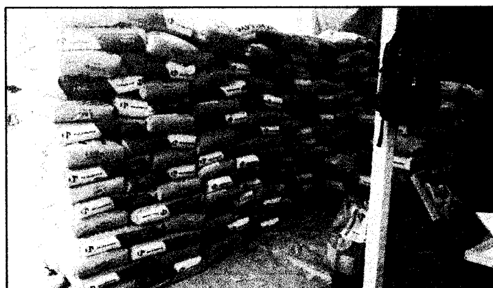
Imagen 2. Acopio de materiales.
