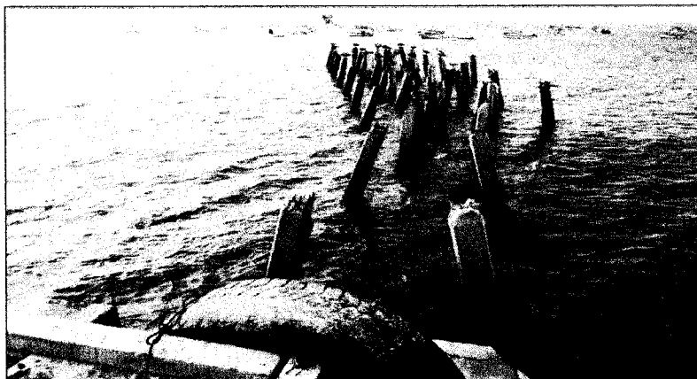
Imagen 4. Demolición del muelle existente.
