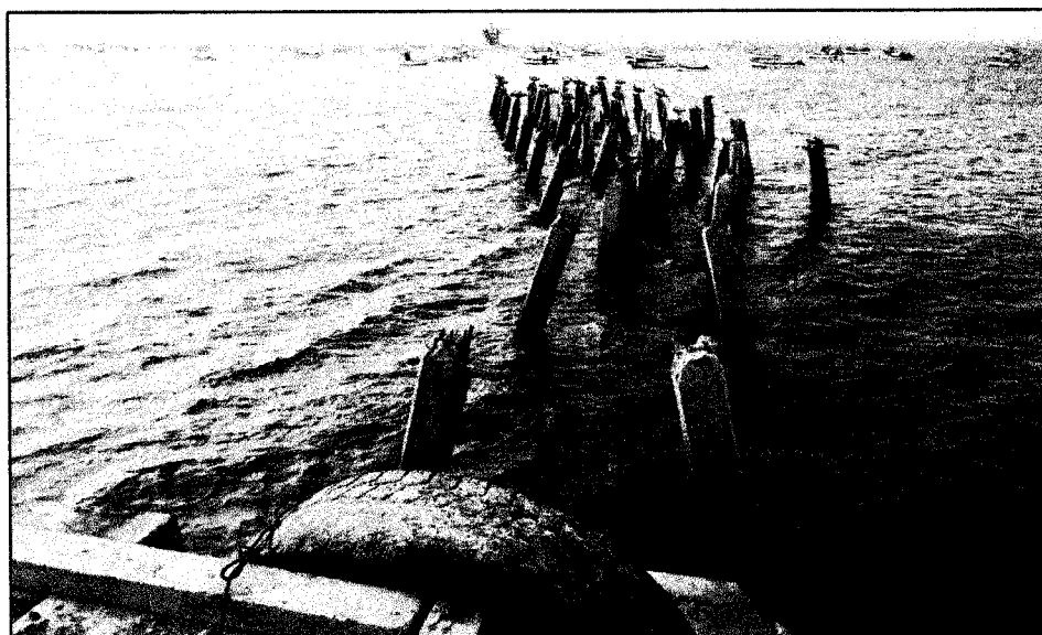
Demolición de puente existente.
