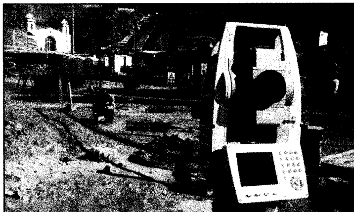
Imagen 6. Replanteo topográfico zonas complementarias.
