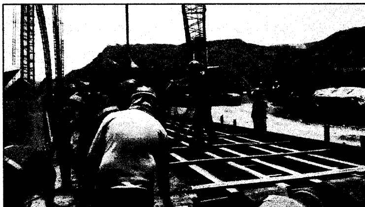
Imagen 9. Fundido de pilotes, sección 0.5 \times 0.5 m
